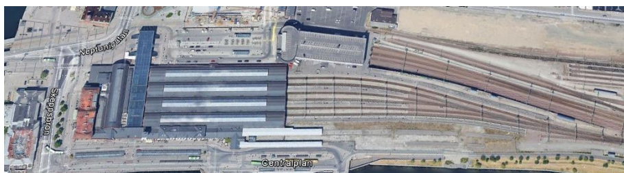
Figur 26. Malmö C, banhall och sex spår ovan mark.
